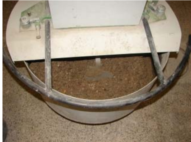
Obr. 9: Příprava betonové směsi
