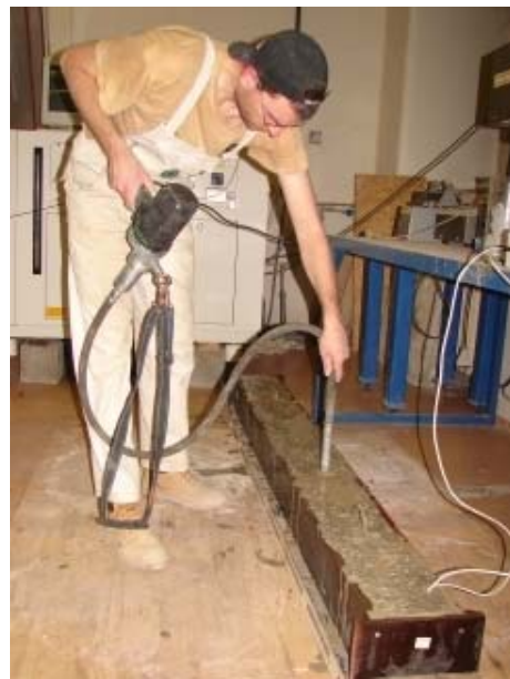
Obr. 11: Hutnění betonu v bednění
