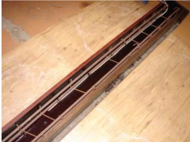
Obr. 8: Pohled do bednění před betonáží
