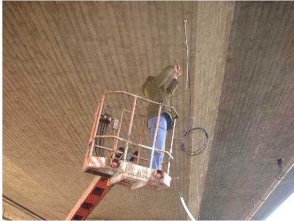
Obr. 4: Instalace optovláknových extenzometrů
