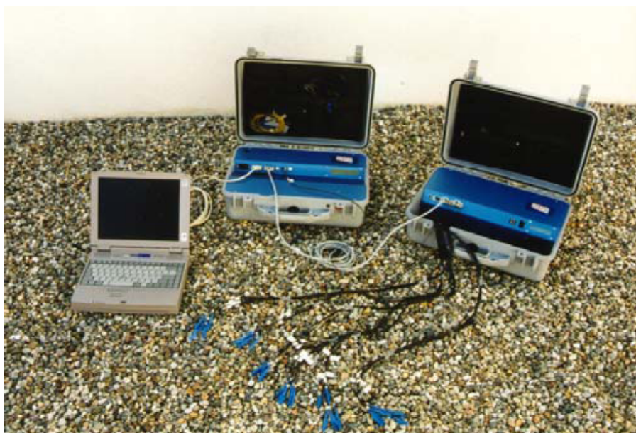
Obr. 3 Měřicí zařízení s řídicím počítačem, jednotkou pro statická měření externím optickým přepínačem (převzato z materiálů firmy SMARTEC S.A.)
