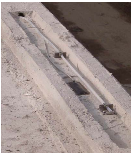
Obr. 7 Instalace příložného extenzometru na betonový nosník (převzato z materiálů firmy SMARTEC S.A.)
