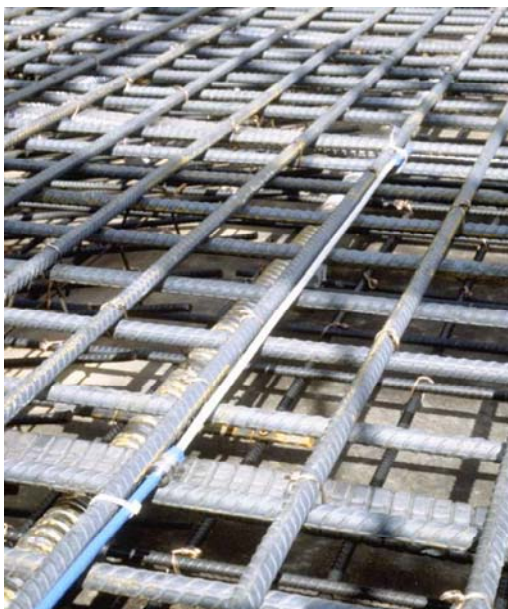
Obr. 6 Optovláknový extenzometr s aktivní délkou 4 m upevněný na výztuži před betonáží (převzato z materiálů firmy SMARTEC S.A.)
