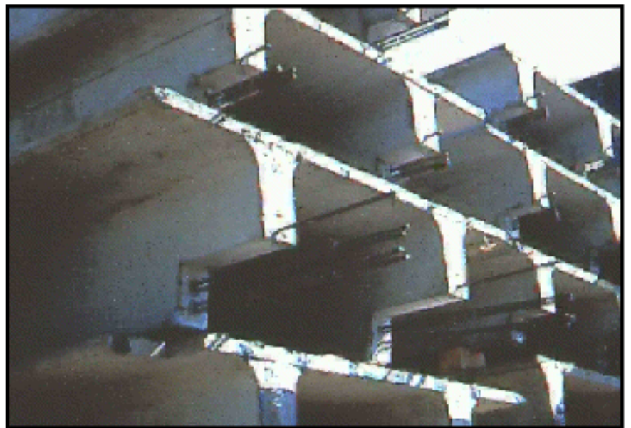
Prefabrikovaný beton – betonáž na ve výrobně, prvky z prostého vyztuženého nebo předpjatého betonu
