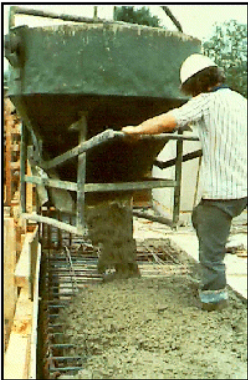
Monolitický beton – betonáž na staveništi
